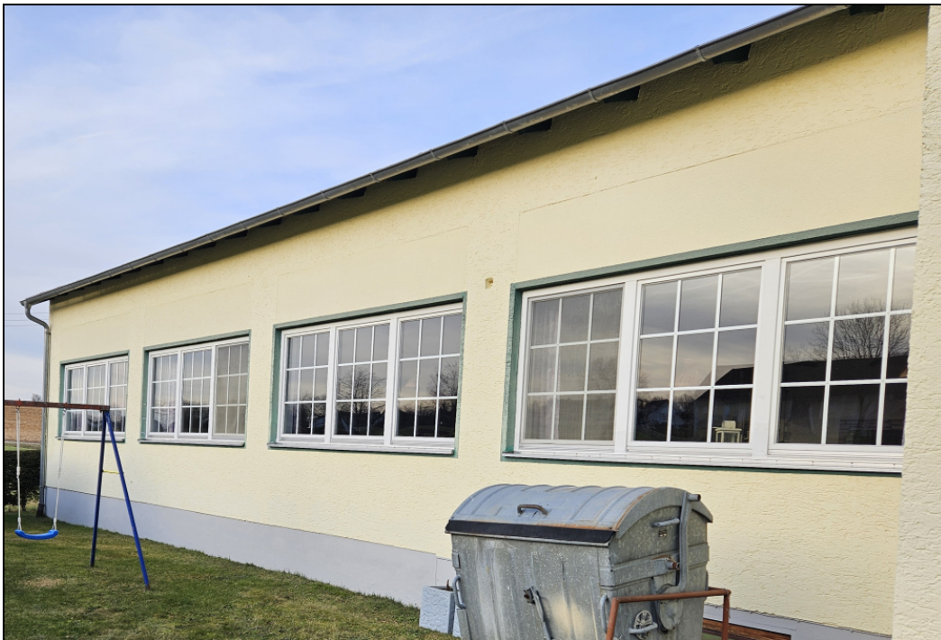
Abb. 6: Saal, Südwestfassade mit 12 Fenstern
